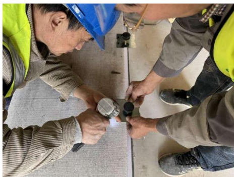
图 5.2.2-2 架空模块安装
