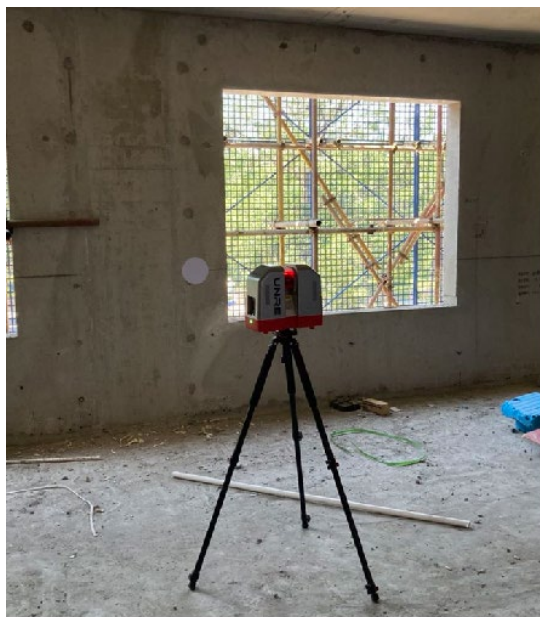
图 5.2.1-1 3D 放线仪现场实测实量
