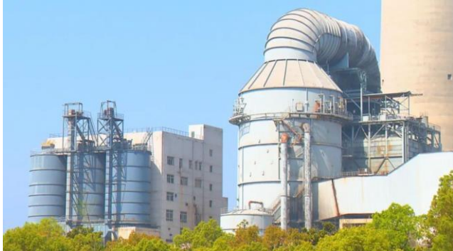
图表：皖能铜陵发电有限公司300兆瓦燃煤机组
