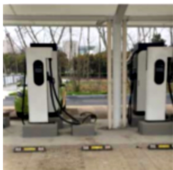
新能源充电桩
