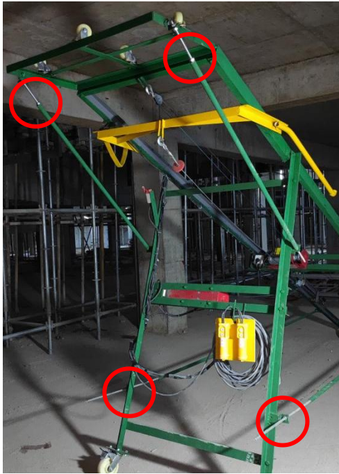
图 5.2.3-3 操作架终端标高、架体位置调节
