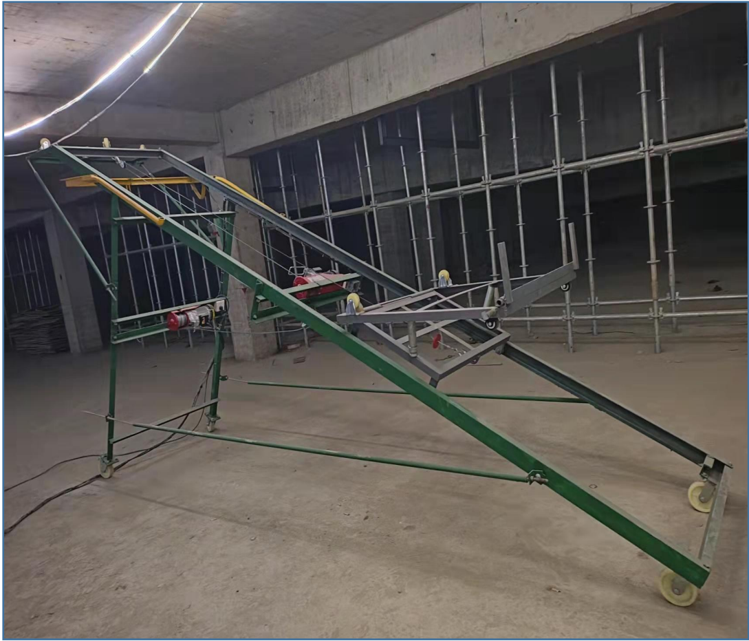
图 4.2.1-2 风管安装提升操作架实物图
