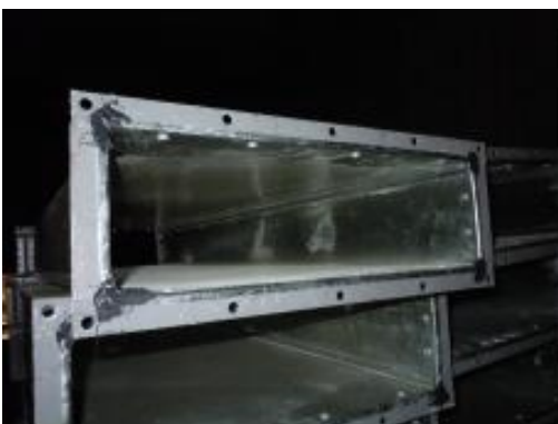
图 5.2.2-1 正压侧打胶
