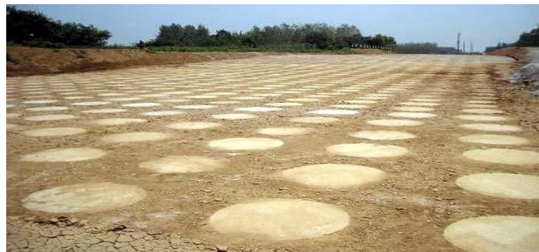
CFG桩复合地基示意图
