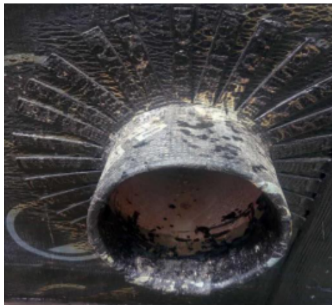
图 6.3-2 穿墙管根防水附加层做法
