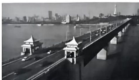
武汉长江大桥
