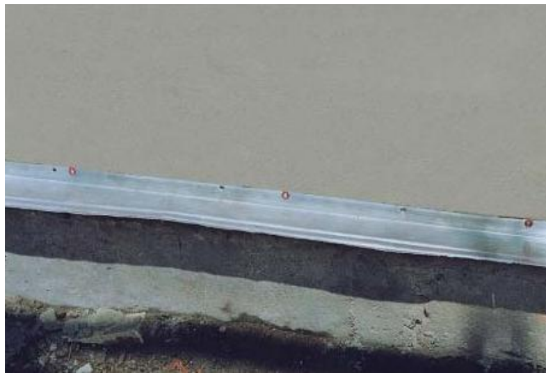
在底部安装铝托架
