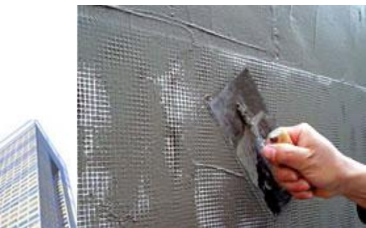
二道抹面砂浆法铺设网格布
