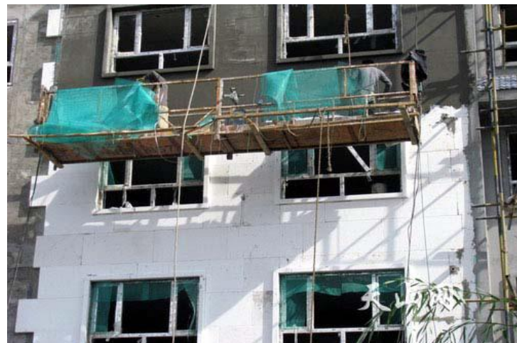
外墙聚苯板铺贴
