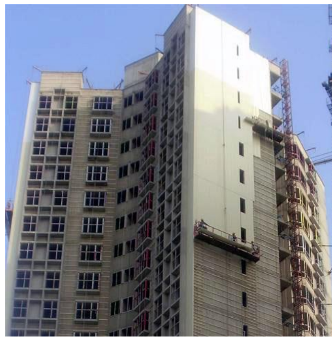
外墙外保温施工
