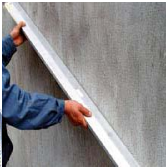
墙面平整度检查
