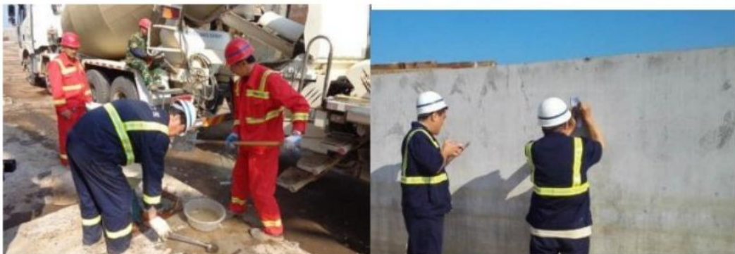
混凝土入模前检查和成型后自检
