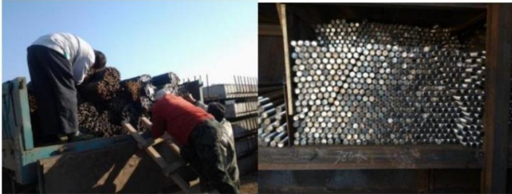
钢材进厂抽检和半成品材料归类存放
