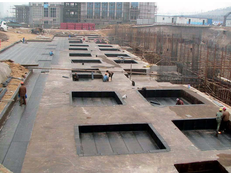
地下室外防内贴法施工
