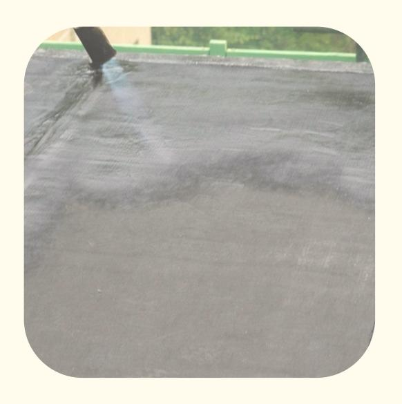
涂层法是一种简单易行的防水方法,通过在混凝土表面涂刷防水涂料,形成一层防水膜,达到防水的目的。
