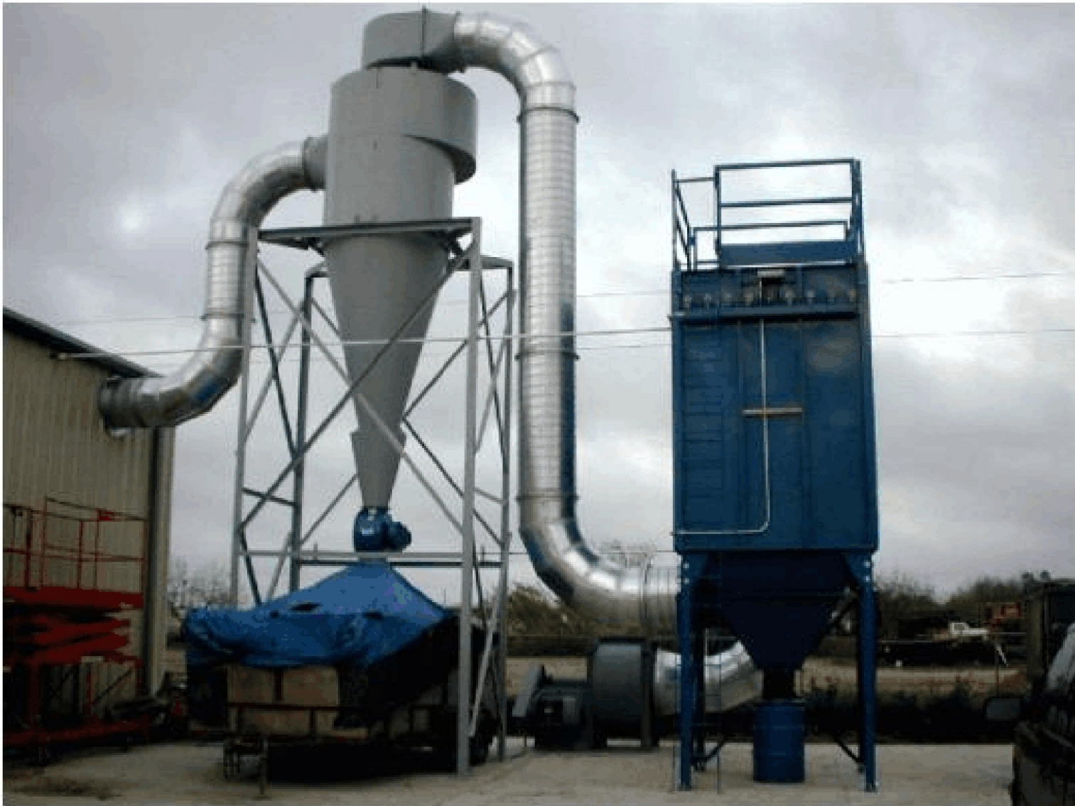
进气管、筒体、锥体、排气管
