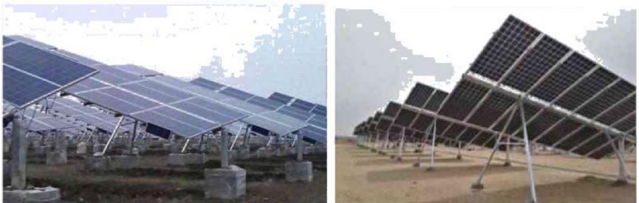
图2-5倾斜单轴跟踪支架光伏安装图
