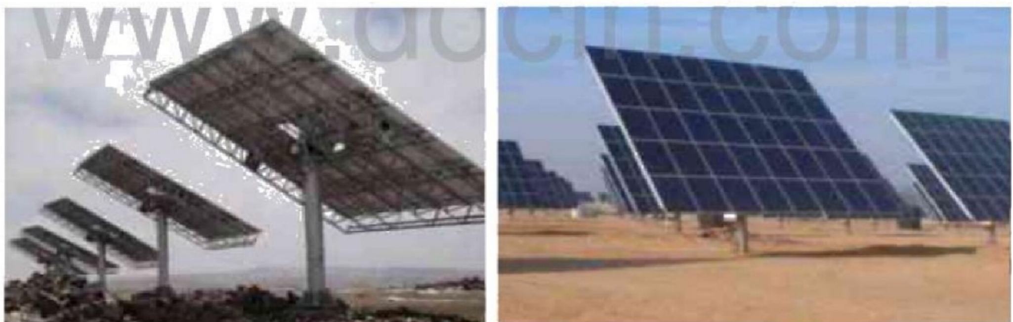
图2-6倾斜单轴跟踪和双轴跟踪式支架光伏安装图
