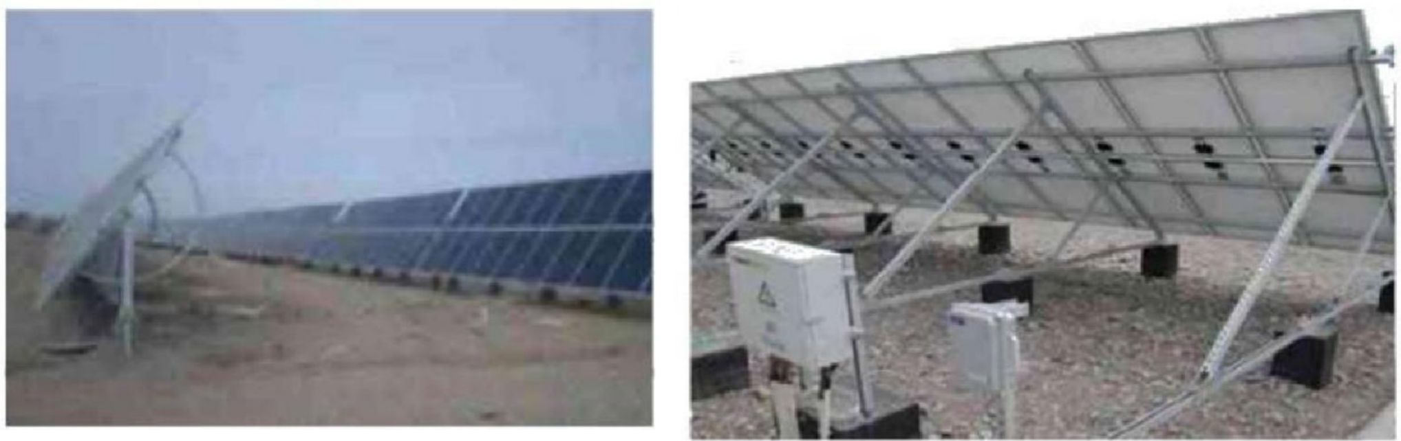
图2-3 圆弧式和推拉杆式可调式光伏安装图
