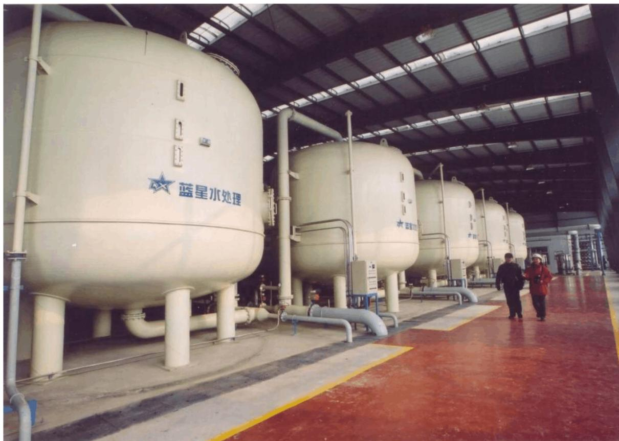
本工艺方案采用 12 台  $\Phi 3200$  多介质过滤器，其中 5 台为原有装置迁移使用，7 台为本次工程新增设备。工艺配备 2 台反冲洗泵，1 用 1 备，1 台利旧，1 台新增，流量  $300\text{m}^3/\text{h}$ ，扬程为 20m，建设钢筋混凝土水池 1 座，容积  $190\text{m}^3$ ，基本尺寸为  $12\text{X}4\text{X}4\text{m}$ 。
