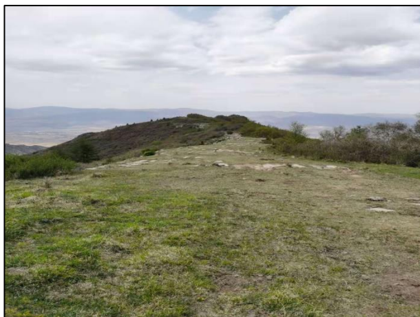
新建检修道路
