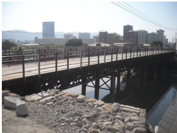
图 4-3 钢栈桥成型样式
