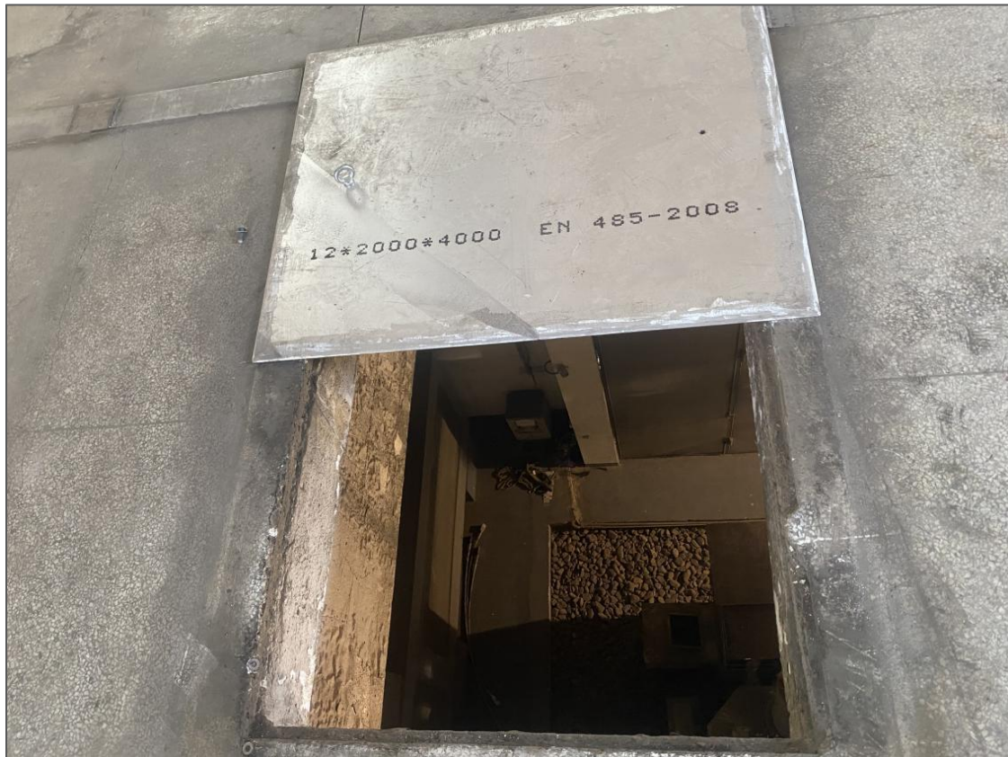
图 5.2.2-1 搬运现场地面坑洞铺设
