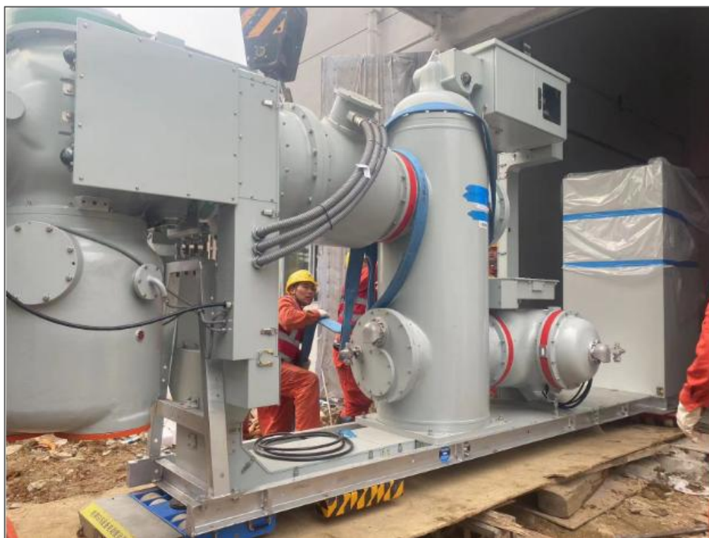
图 5.2.3-1 重件设备吊装至电动搬运平台
