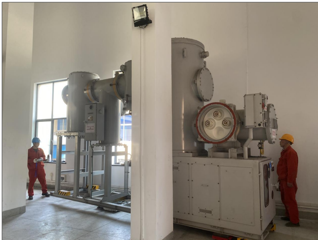
图 5.2.4-1 操作人员进行重件设备搬运
