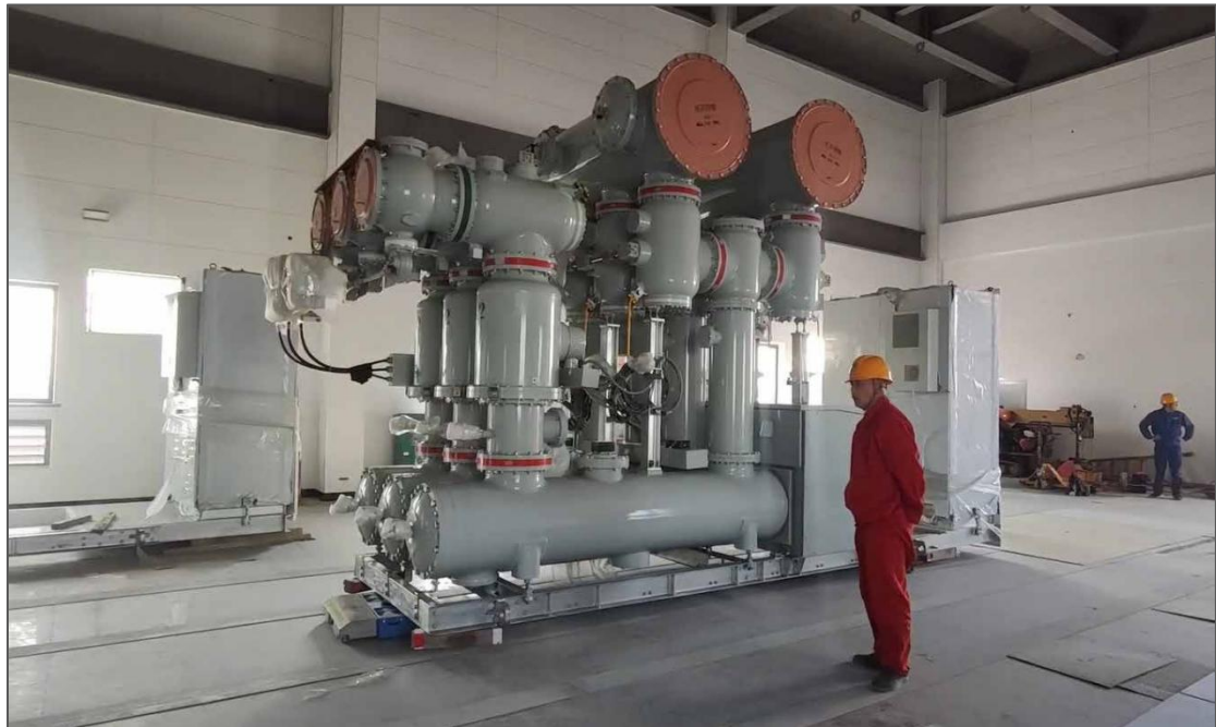
图 1.0.0-1 电网重件搬运套装室内搬运 GIS 设备施工现场
