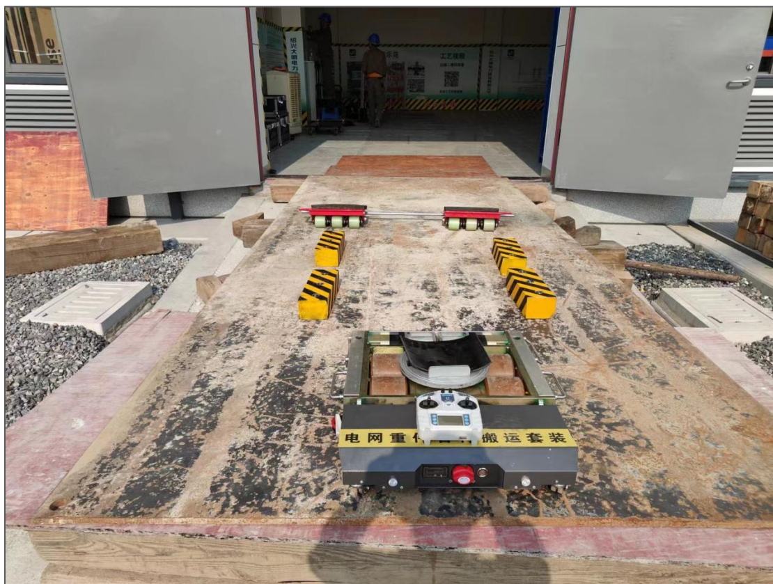
图 5.2.2-2 重件设备吊装前电动搬运装置布置
