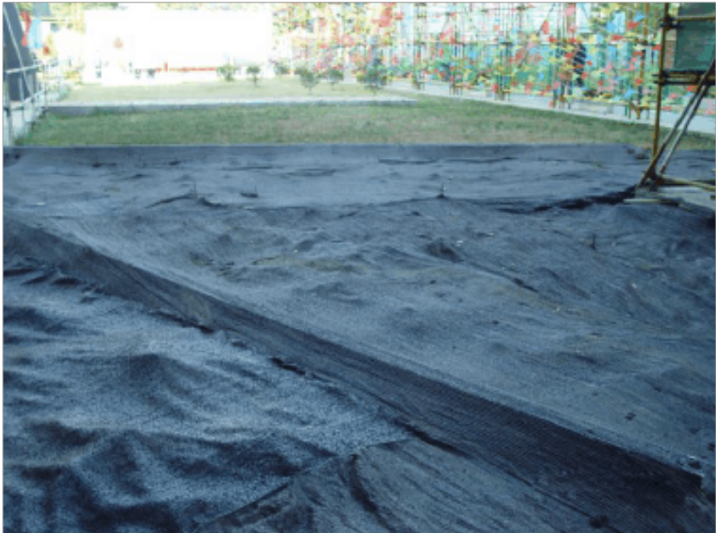
裸露的场地用防尘网覆盖
