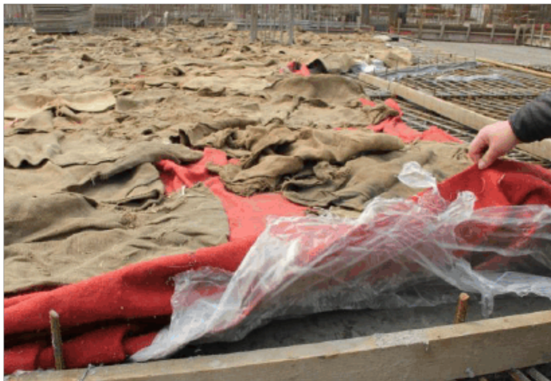
混凝土养护采用覆盖保水养护
