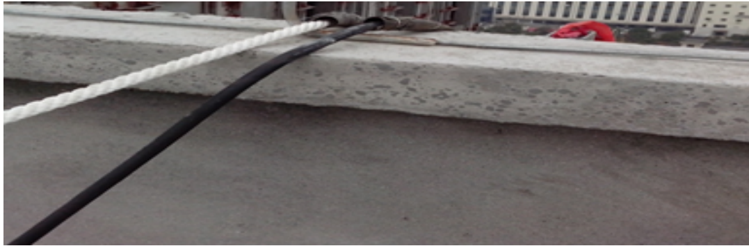
安全绳和电缆线用橡胶保护并固定在钢筋混凝土梁上
