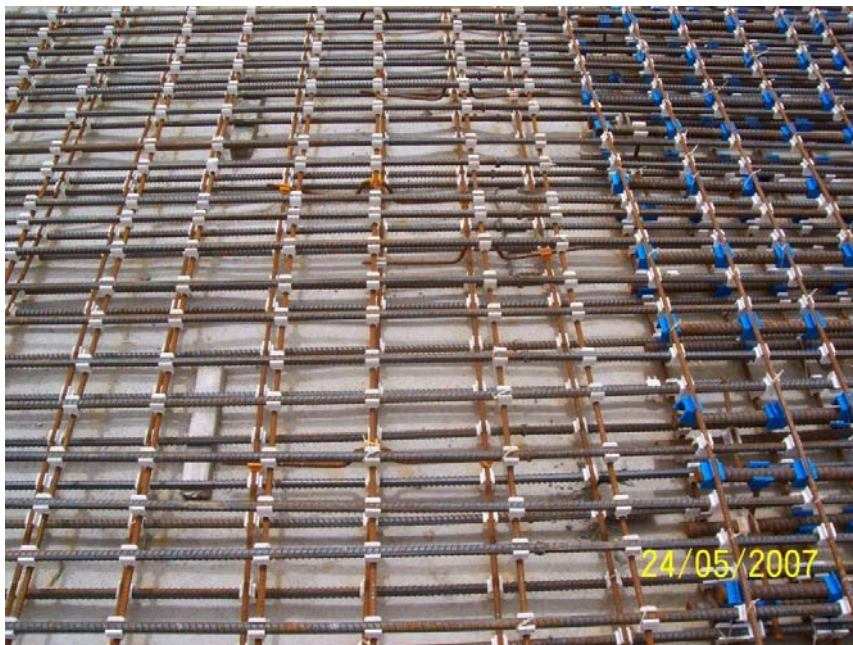
电气绝缘的钢筋
