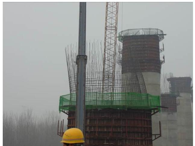
由于墩身坡比为下口大上口小，且下部模板始终使用 32mm 的拉丝进行对拉，下部模板满足支撑上部模板的稳定与平安的要求。以后每次浇筑混凝土，钢筋绑扎、撤除下部模板、使用吊车立模、安装步梯、测量定位、浇筑混凝土、养生和标高复核的循环作业，直至到达设计高度。
