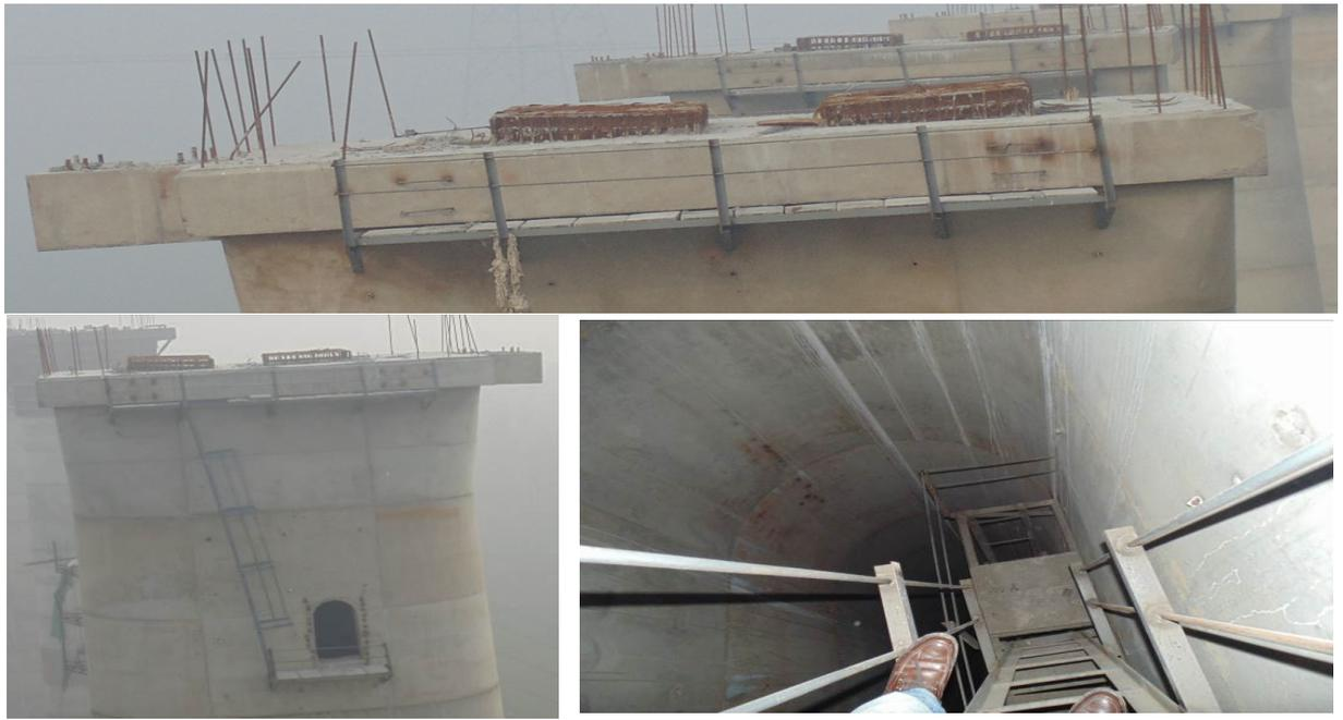
预埋件的预留长度、几何尺寸需要严格按照设计图纸,尤其是预埋螺栓,需要考虑预留在外面的长度。当预埋件与内部钢筋有冲突时,适当调整墩身钢筋来满足预埋件的位置
