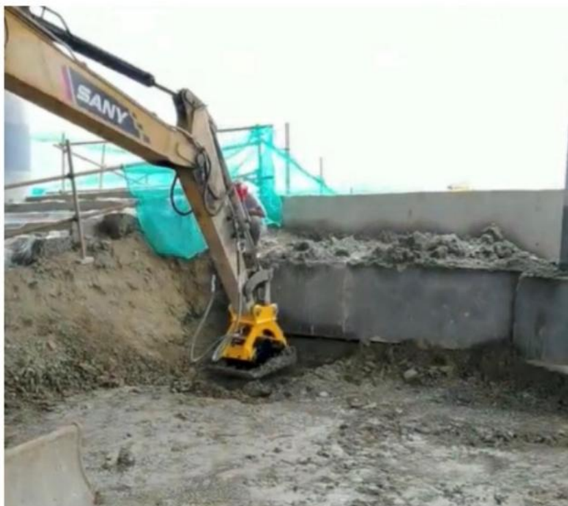
图5.2-3 挖机配震动板
