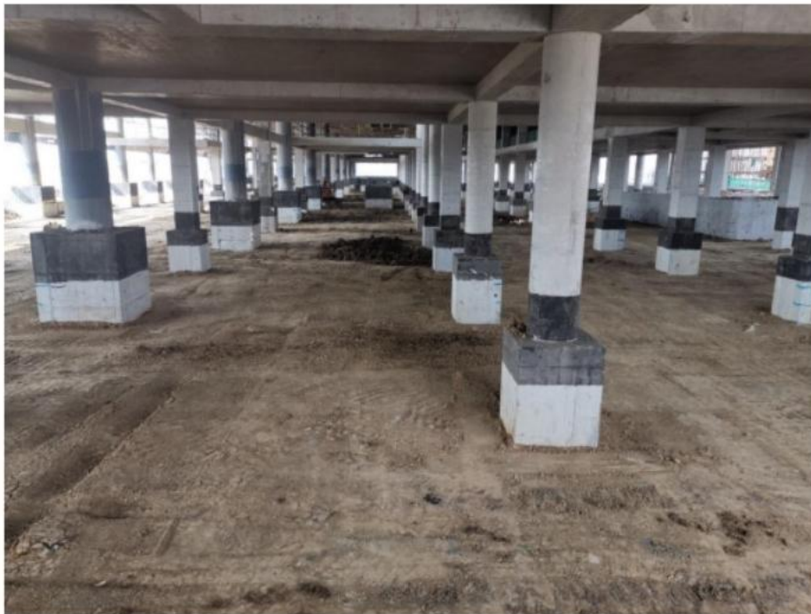
图2.2-2航站楼工程现场勘查
