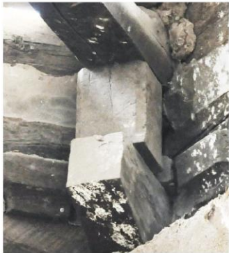
殿内西北转角处蜀柱残件
