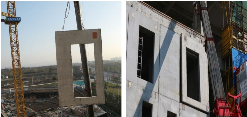
图 5.2.8-2 外墙挂板吊装就位
