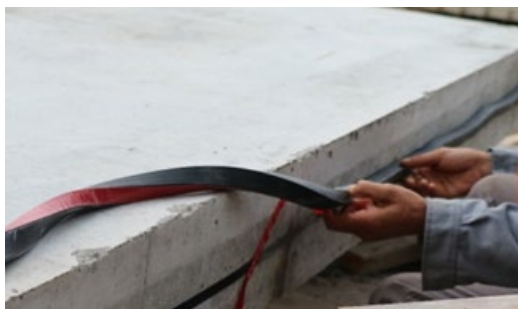
图5.2.7-1 橡胶气密条粘贴
