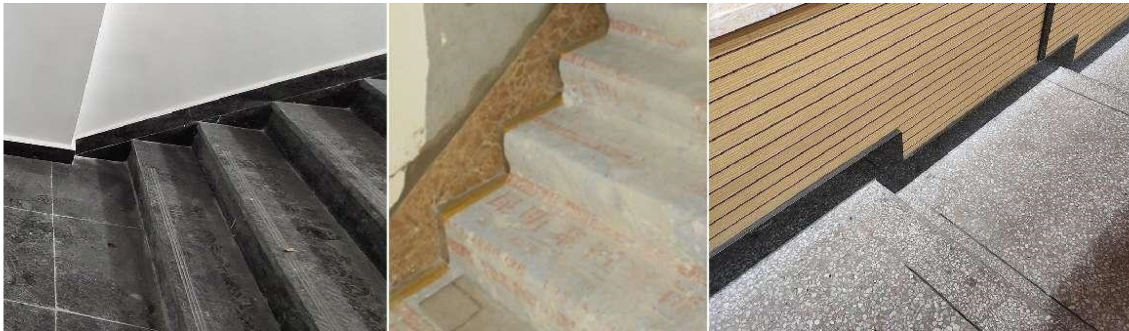
图 3-82 楼梯部位的瓷砖踢脚线处理
