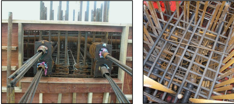
图 4.3-6 预应力锚(垫)板安装示意图
