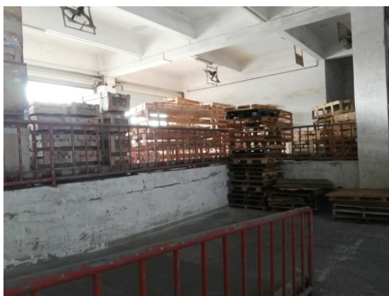
东南側装卸台
