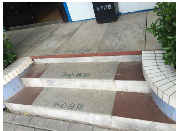
图1.4-6 大理石台阶地面做法实例图
