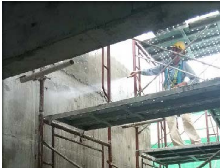
图2.3-1 高压水枪冲洗墙面
