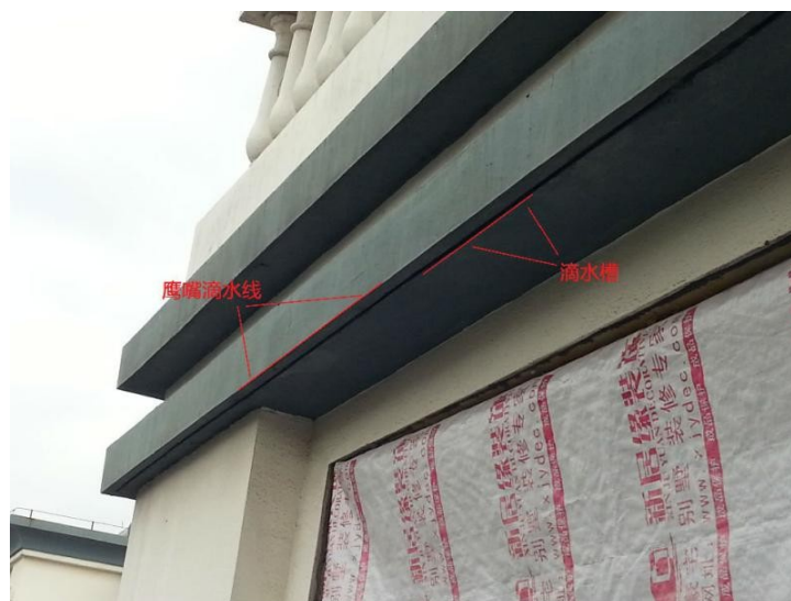
图2.1-4 窗户滴水槽做法实例图
