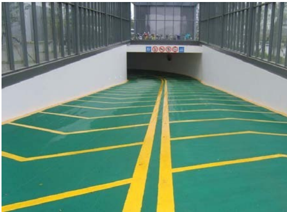
图1.3-3 环氧树脂坡道地面做法实例图
