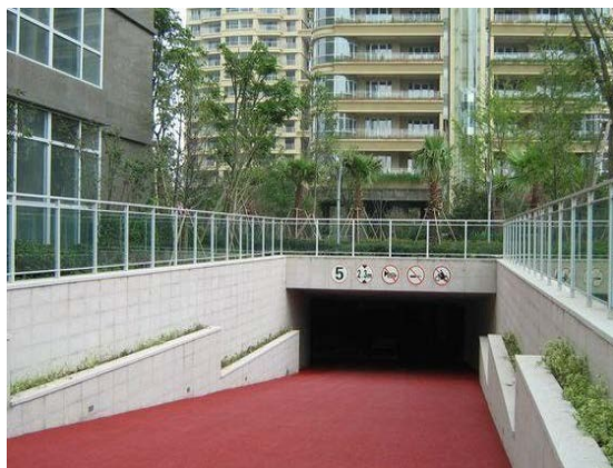
图1.3-5 彩色沥青车道地面做法实例图
