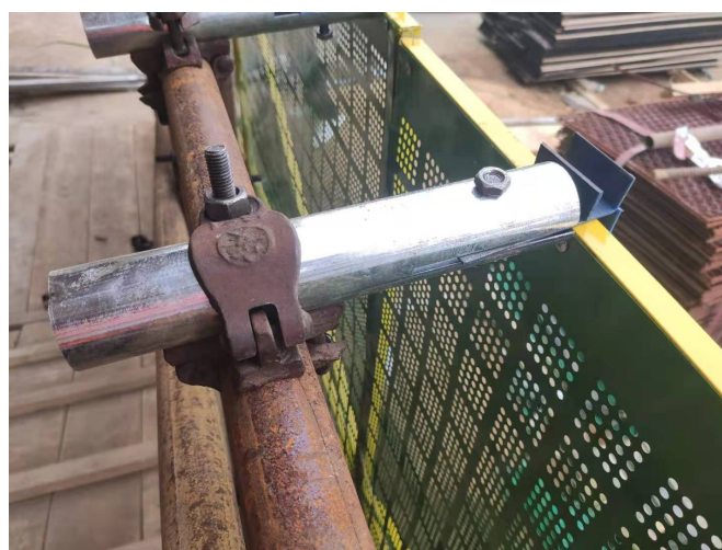
图 6.3.9-1 爬架网安装示意图
