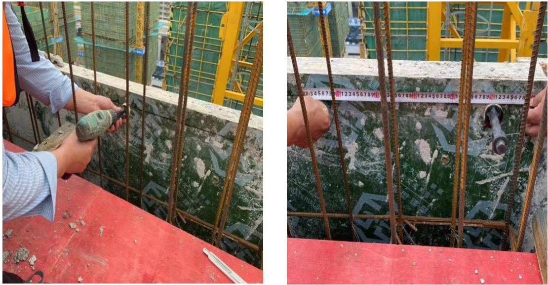
图 5.2-2 紧固件塑料套管固定及校核
