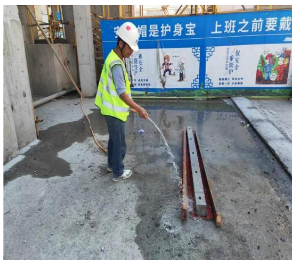
图 5.2-6 模板拆除及混凝土养护
