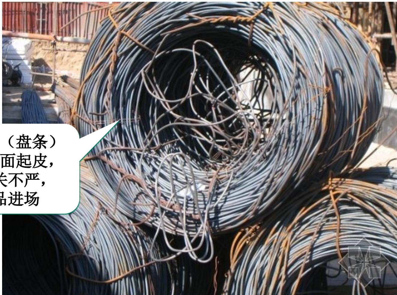
钢筋加工前未审批钢筋下料单，加工时造成大量箍筋成品尺寸不合格，无法用于工程，损失严重
