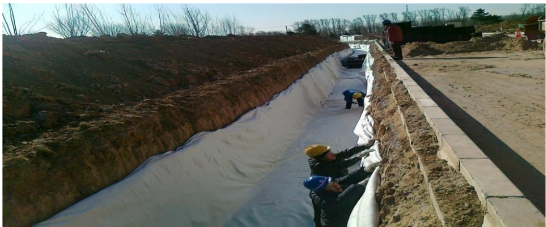
图 5.2.2-1 铺设四周渗透土工布
