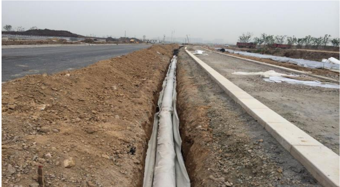
图 5.2.4 渗透管及连接管安装
