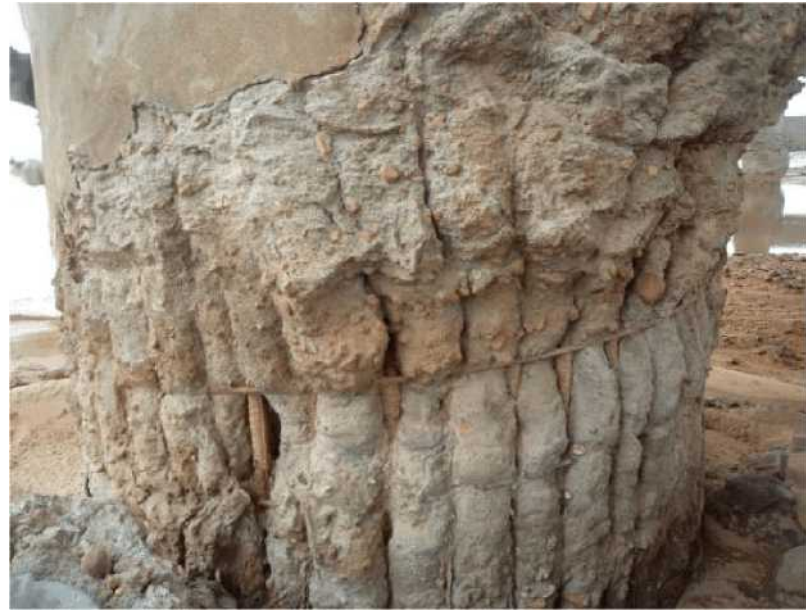
混凝土脱落
