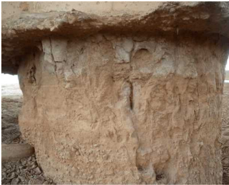
混凝土腐蚀
