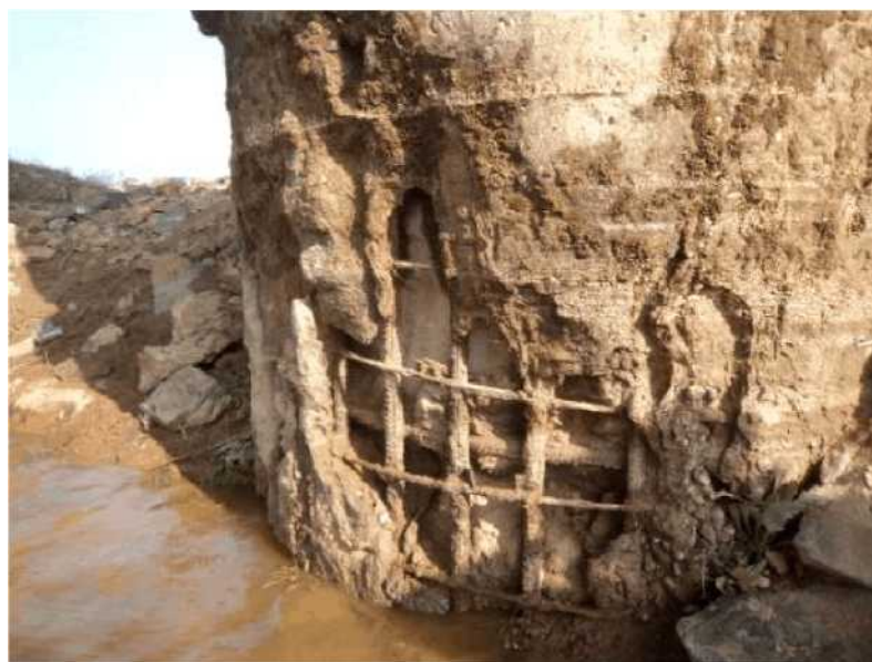
混凝土空洞
