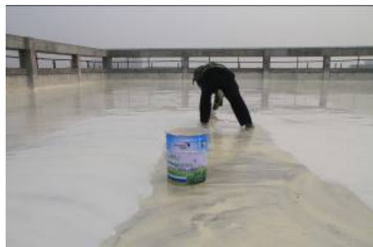
白色聚氨酯防水涂料（固含量 95%以上）的施工（白色、无法添加上述深色有害杂质）
