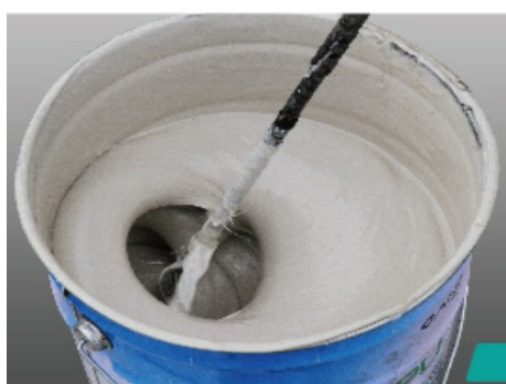
白色聚氨酯防水涂料（固含量 95%以上）的施工（白色、无法添加上述深色有害杂质）
