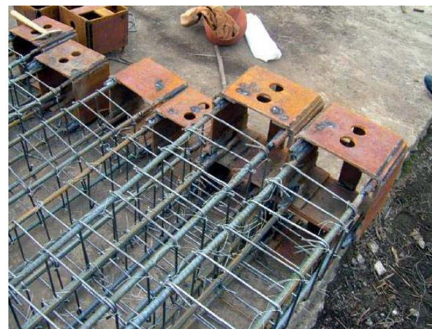
桩端钢筋构造
