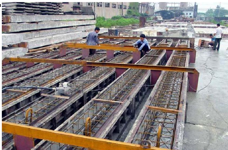
桩身钢筋绑扎
