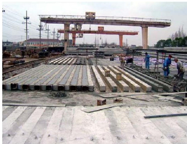
预制方桩的间隔生产
