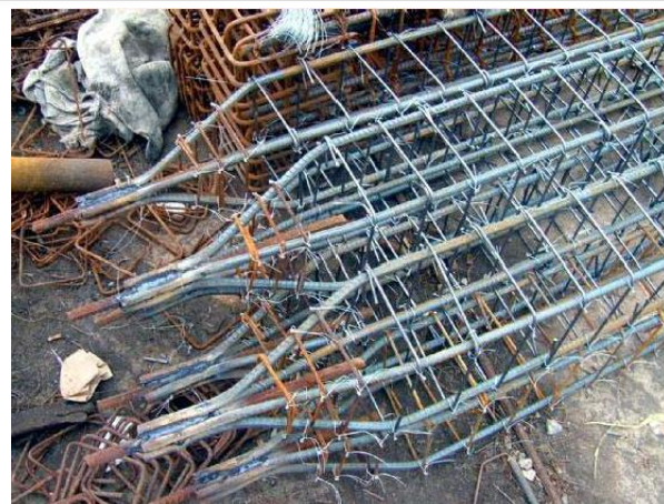
桩尖钢筋构造
