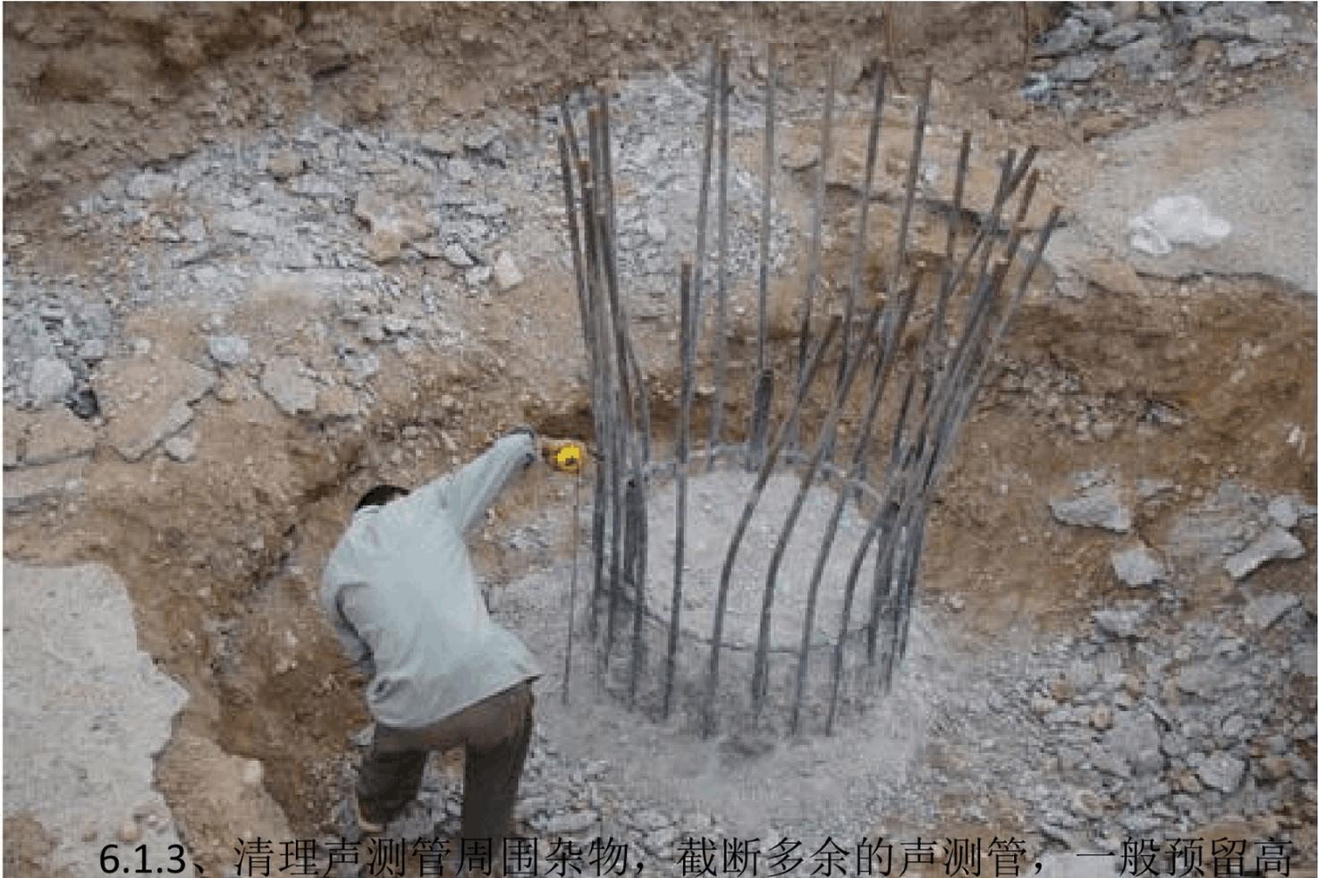
**6.1.3、清理声测管周围杂物，截断多余的声测管，一般预留高于桩基顶面 30-50cm，疏通声测管，使声测管通畅，并用测绳拴一根 32mm 长约 20 cm 的钢筋，做成吊锤对声测管进行试探是否畅顺，保证检测探头能在管内顺利提升及下降，不卡壳，并将声测管中注满清水。每埋设一节，均应向声测管内加注清水作为检测用的耦合剂。水不能直接用江水，尤其汛期江水含泥量较高，要经过净化处理后才能用来灌声测管，来达到预防声测管底部堵塞的目的。在灌注基桩水下混凝土之前，应检查声测管内的水位，如管内的水不满，则应及时补充灌满。**
