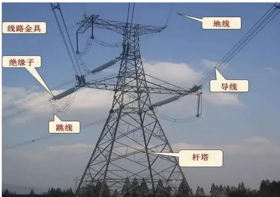
图 2.1 架空输电线路构成图
