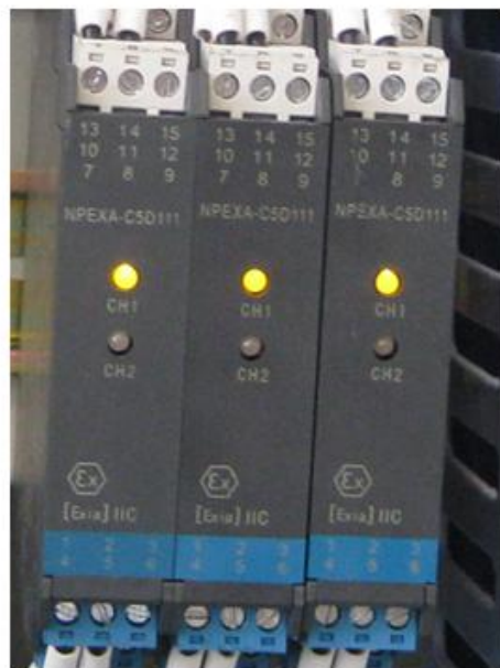
隔离栅未打开前盖板
