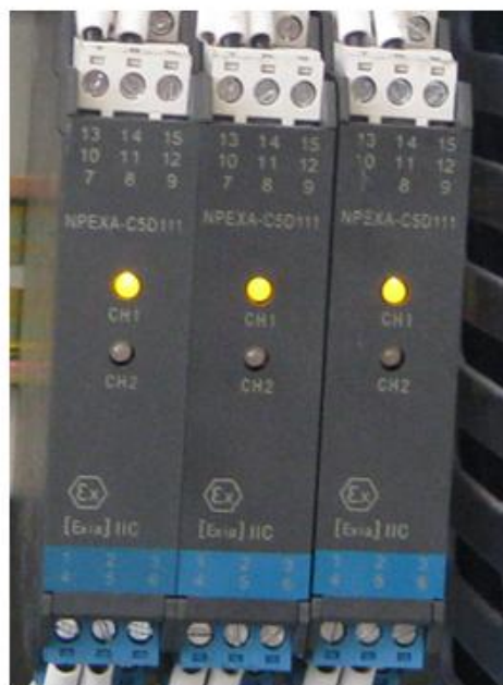
隔离栅未打开前盖板
