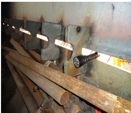
间隙在40mm，装配用的马板已安装好
