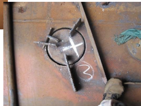
补孔没有按照标准要求进行，仅为200mm
