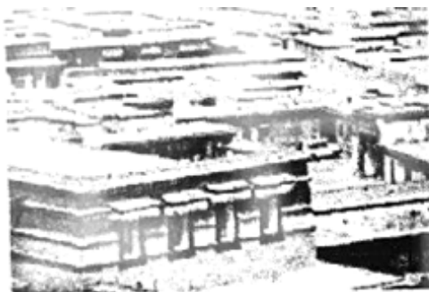
甘肃夏河县土墙平顶屋
