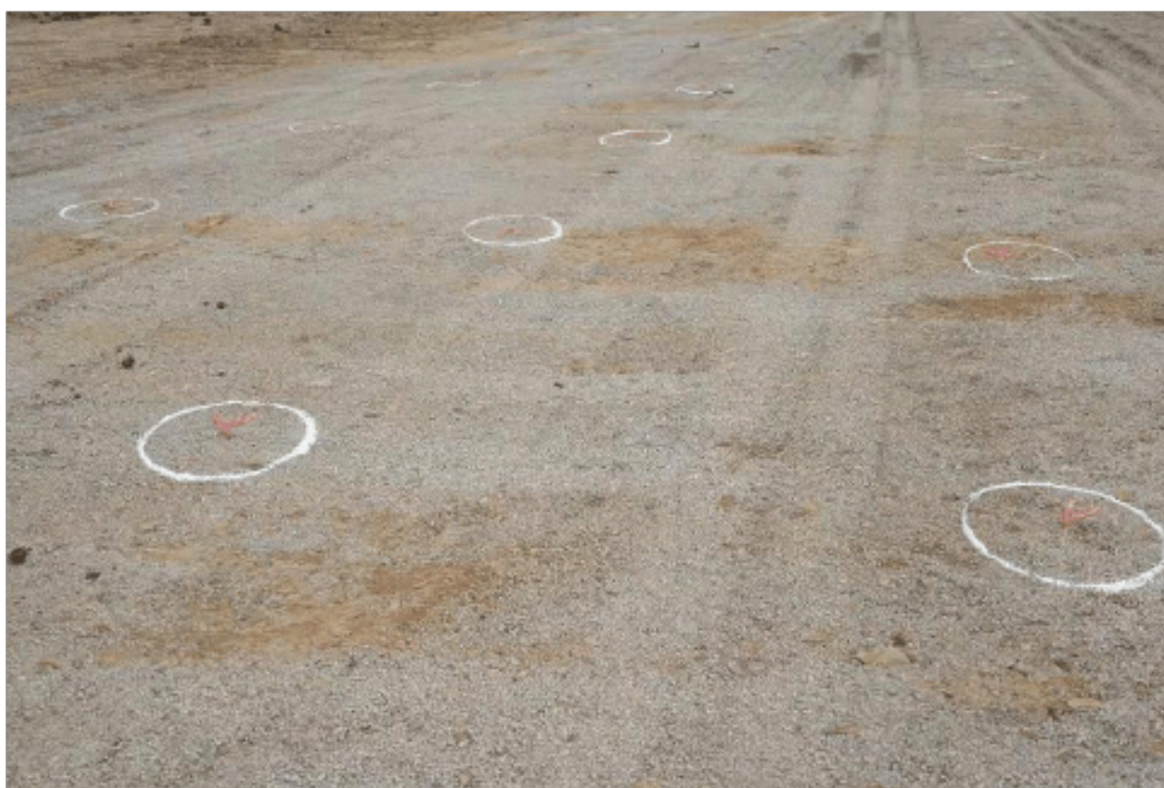
试桩作业场地平整、桩位定位
