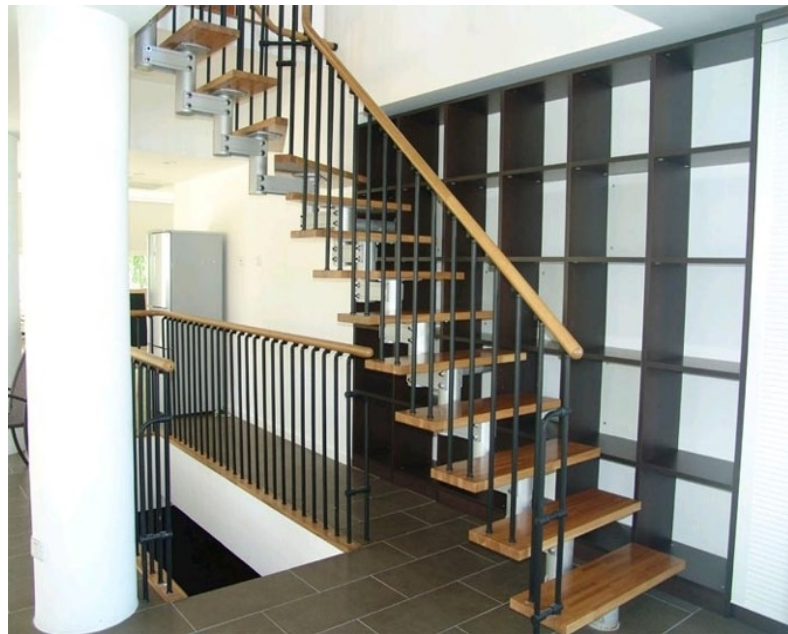
图14-2-6 钢-木混合构造梁式楼梯
