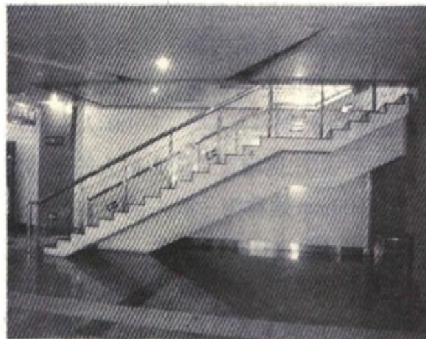
图 14-2-3 混凝土梁式楼梯
