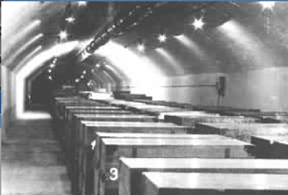
辽宁省档案馆的洞库
