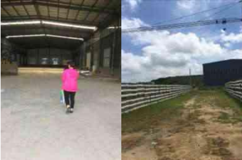
图1 本项目现场勘查照片
