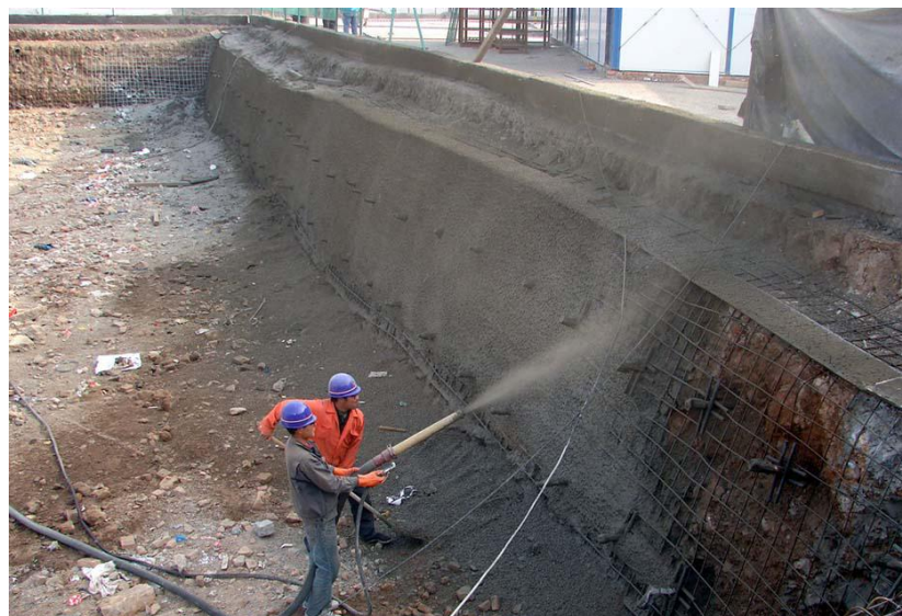
基坑的喷锚支护
