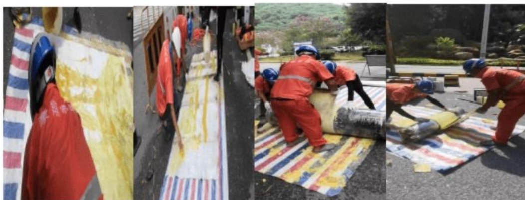
图3-3局部现场固化法施工过程示例图
