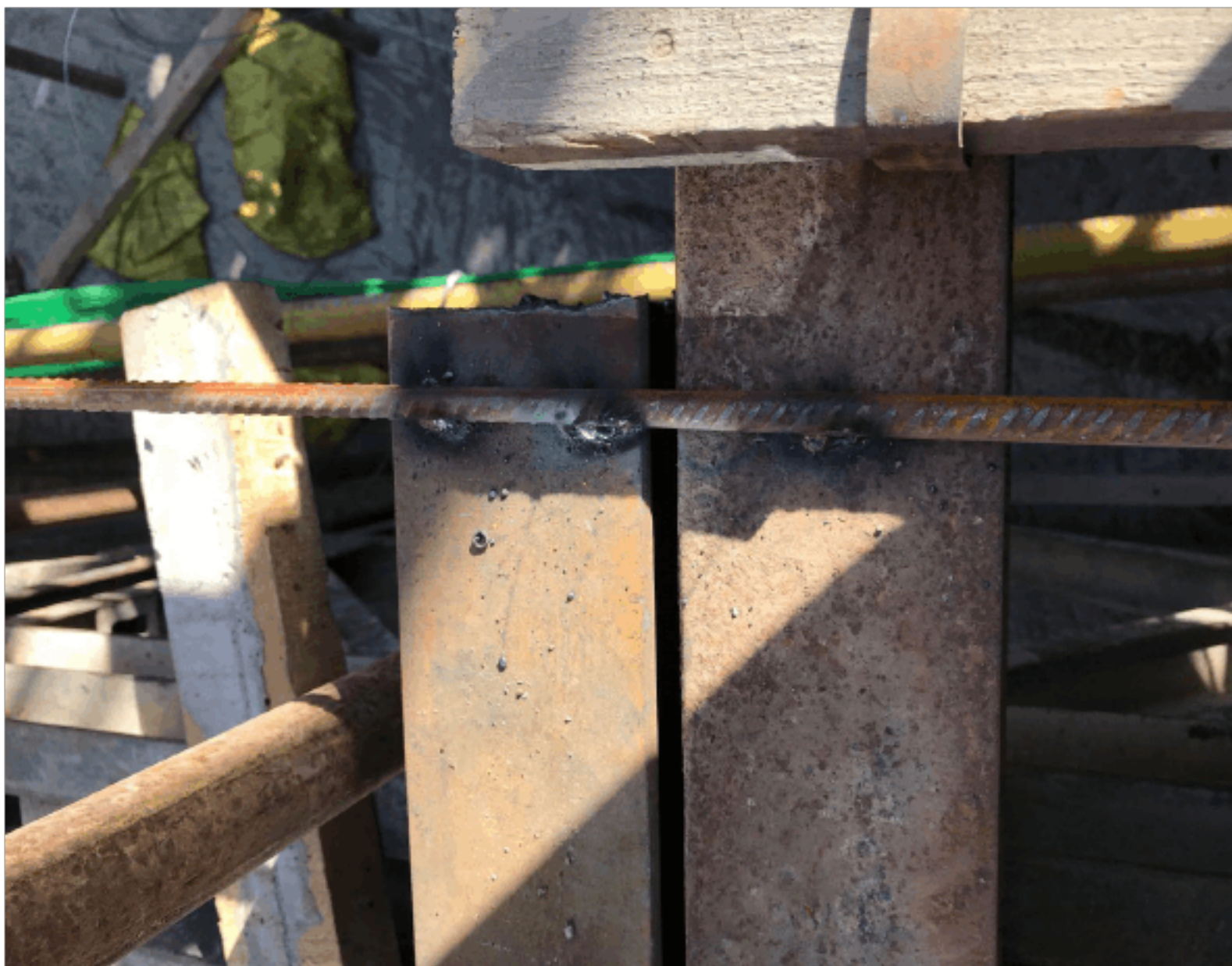
图 5.6-1 工字钢使用钢筋焊接连接成整体
