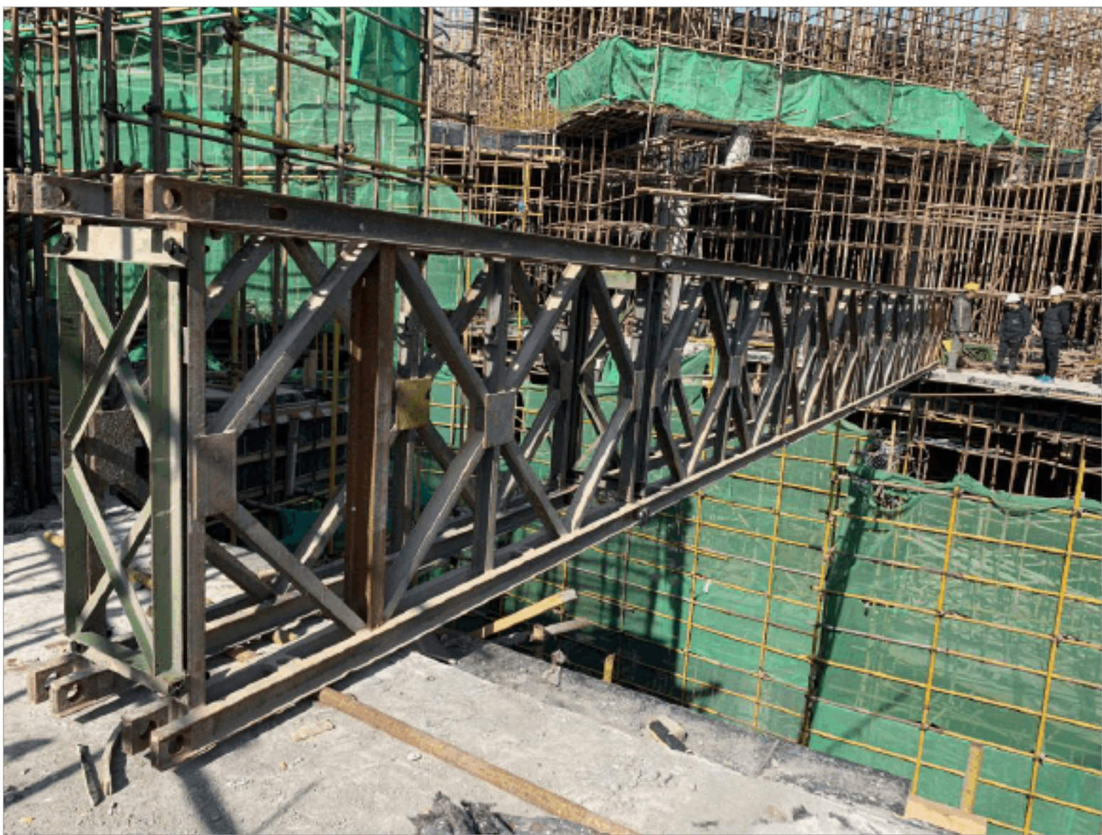
图 5.4-3 贝雷梁花架连接示意图
