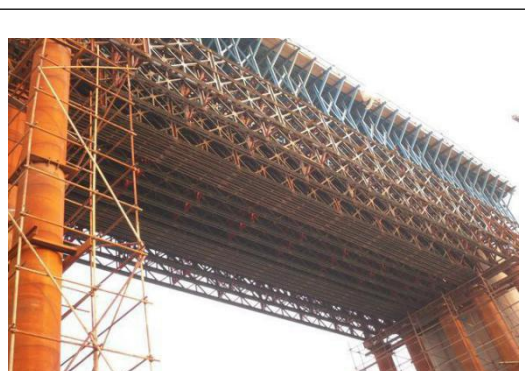
图2.12 钢管贝雷支架
