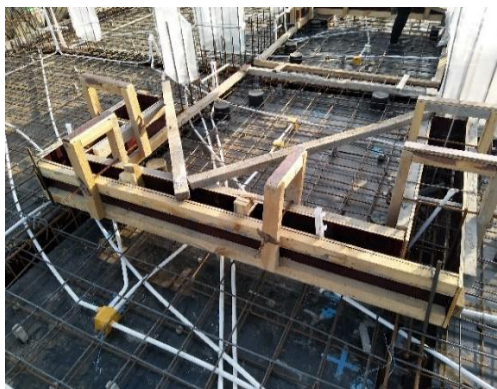
图4.3 砼翻梁模板一次支设
