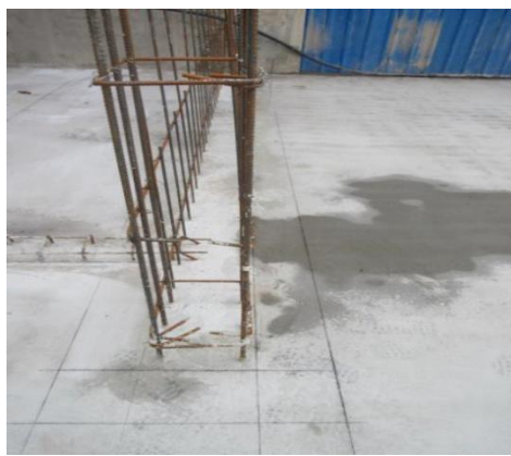
图3.2 墙体位置定位控制
