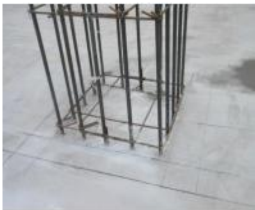
图3.1 柱定位控制
