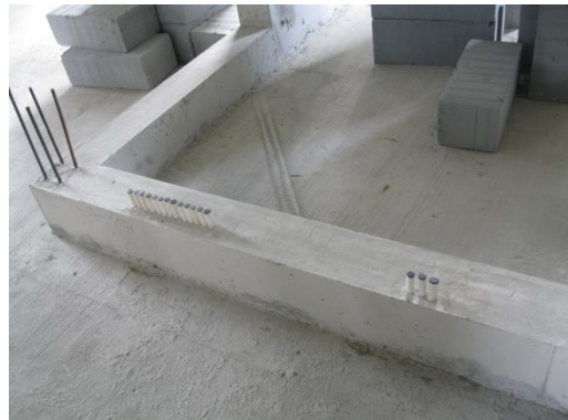
图4.4 砼翻梁一次浇筑成型
