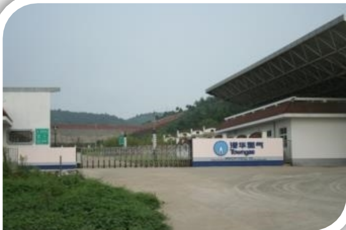
一座天然气门站
