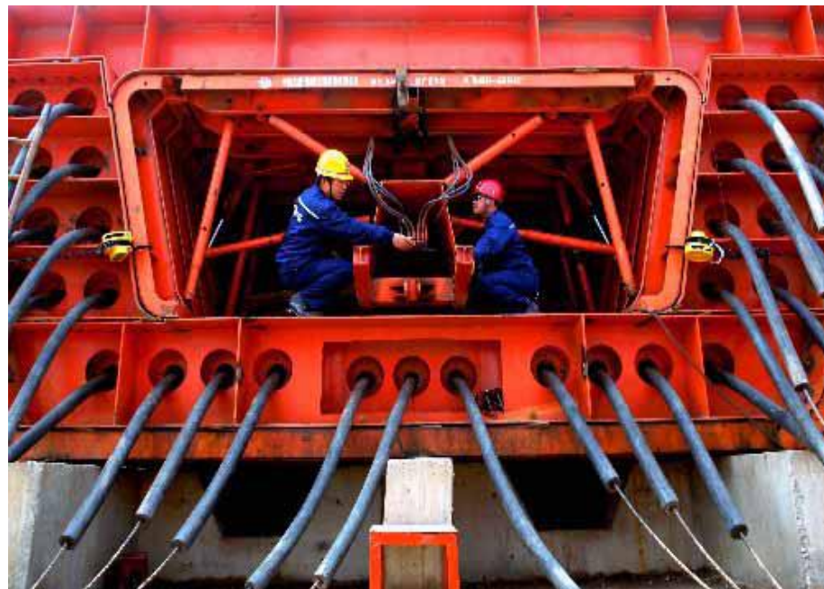
箱梁端部模板作张拉台座
